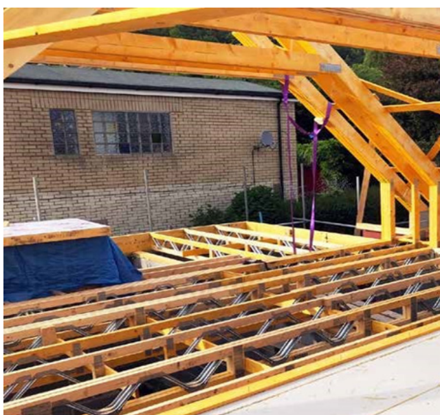
Posi-ramverk på byggsplats.
