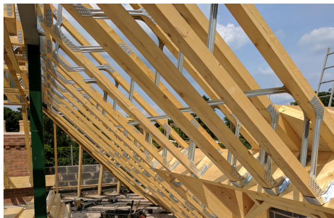
Posi-Joist-åsar med upplag på stål balk inock.
