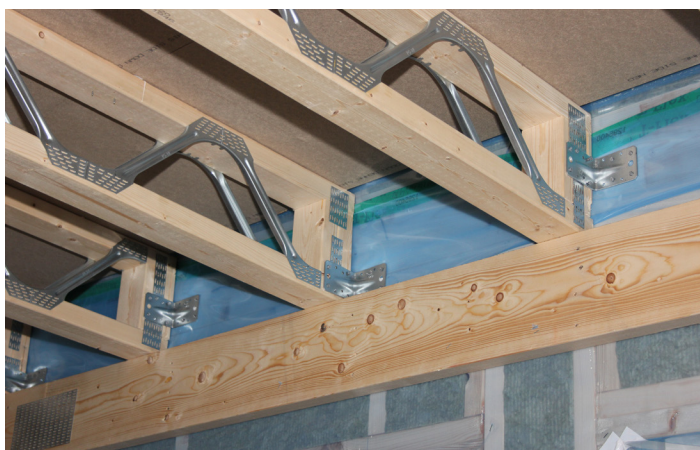
Här vilar Posi-Joists på fastsatt horisontell väggregel/balk. För bättre och säkrare stabilitet under montering har man fäst vinkelbeslag (observera att ej skada befintliga spikbleck).
