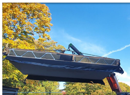
Lyft och flytt av Posi-Joist-kassett med kran.
