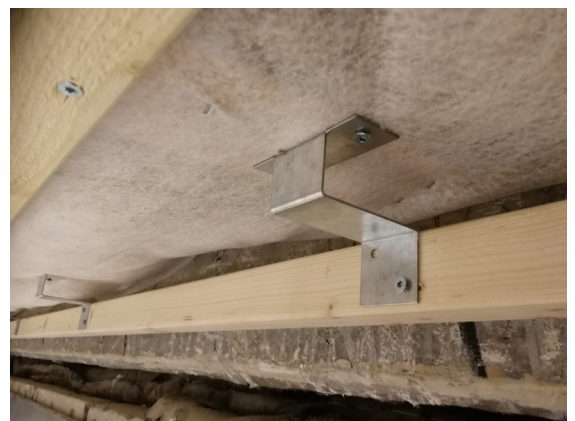
Ljudprofil monterad på detta vis har efter tester visat ge den bästa vibrationsdämpningen, enligt uppmätningar med *japanska bollen*. Observera att om regeln monteras på andra sidan av ljudprofilen (kontakt på två sidor) ger detta ett sämre resultat, även fast den varianten också klarar ljudkraven.
