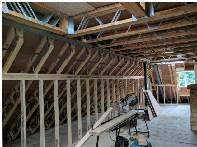
Fastplåttad änddetalj har upplag på hammarband.
