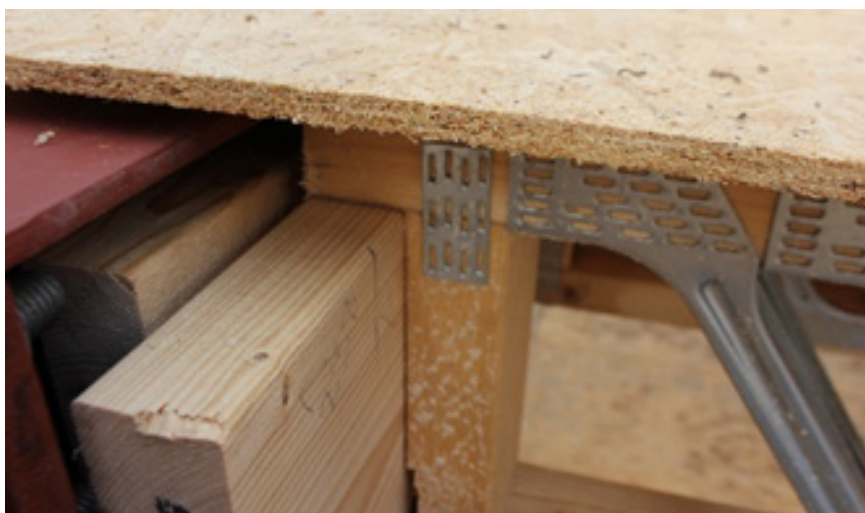
Upphängning mot stålbalk utan balkskor.
