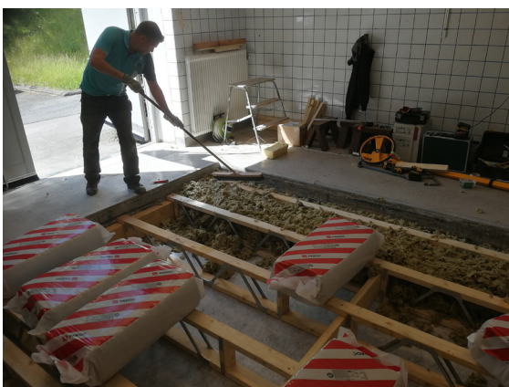
Lösullsisolering kan enkelt täcka alla utrymmen i Posi-Joist-bjälklaget.
