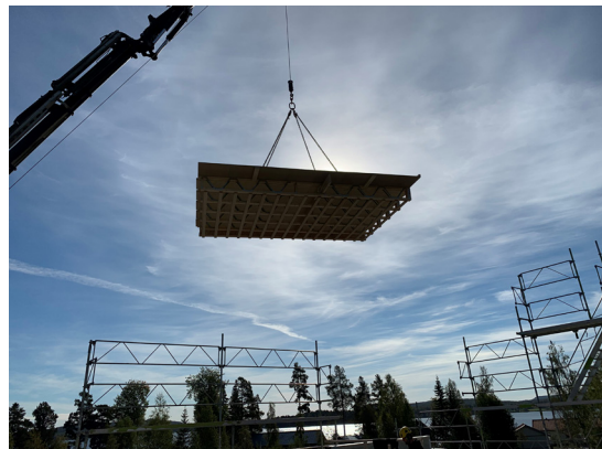
En Posi-Joist-golvkassett lyfts på plats med kran.
