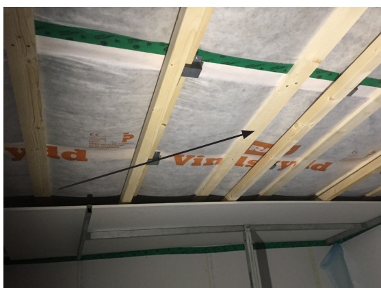
Pil pekar på stödregel som monterats mellan de nedhängda undertaksreglarna.
