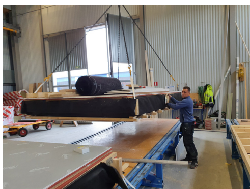
Lyft och flytt av Posi-Joist-kassett i fabrik.
