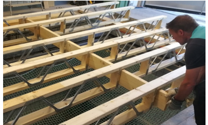
Sviktavstyvning monteras för spännvidder längre än fyra meter.
