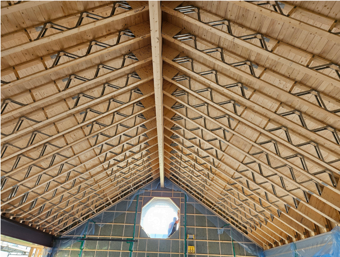
Posi-Joist som används i takkonstruktion: "Posi-Rafter"
