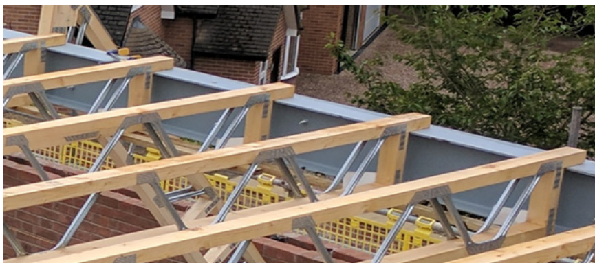
Posi-Joist med överram vilandes på stålbalkens topp.
